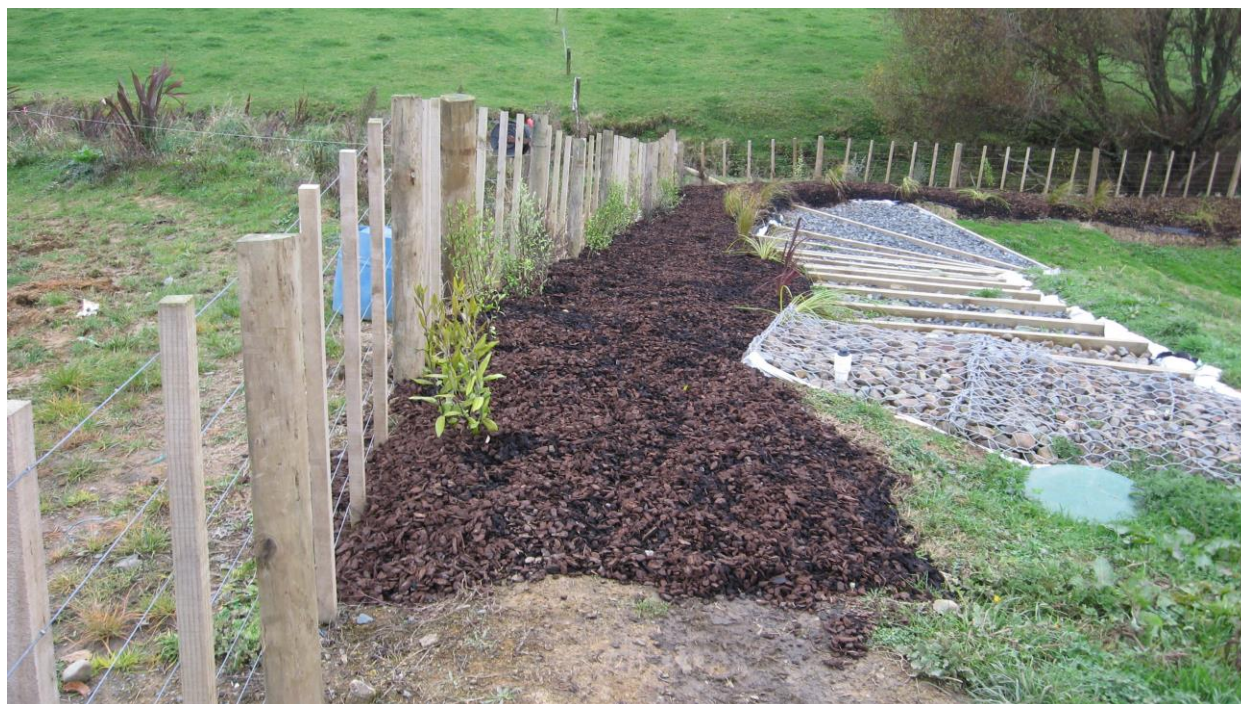
Fig. Piopio effluent outfall
